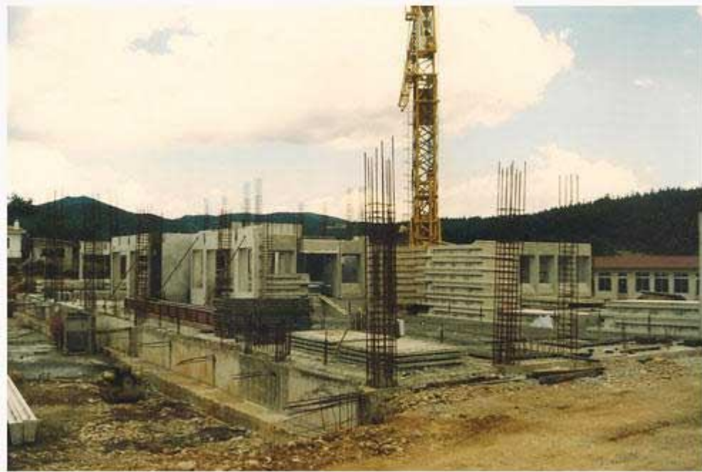
Εικόνα 7: Το 1998 στήθηκε το νέο προκατασκευασμένο Σχολείο
